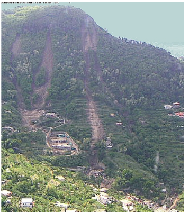
Fig. 7.3: La frana del 30 Aprile 2006.
